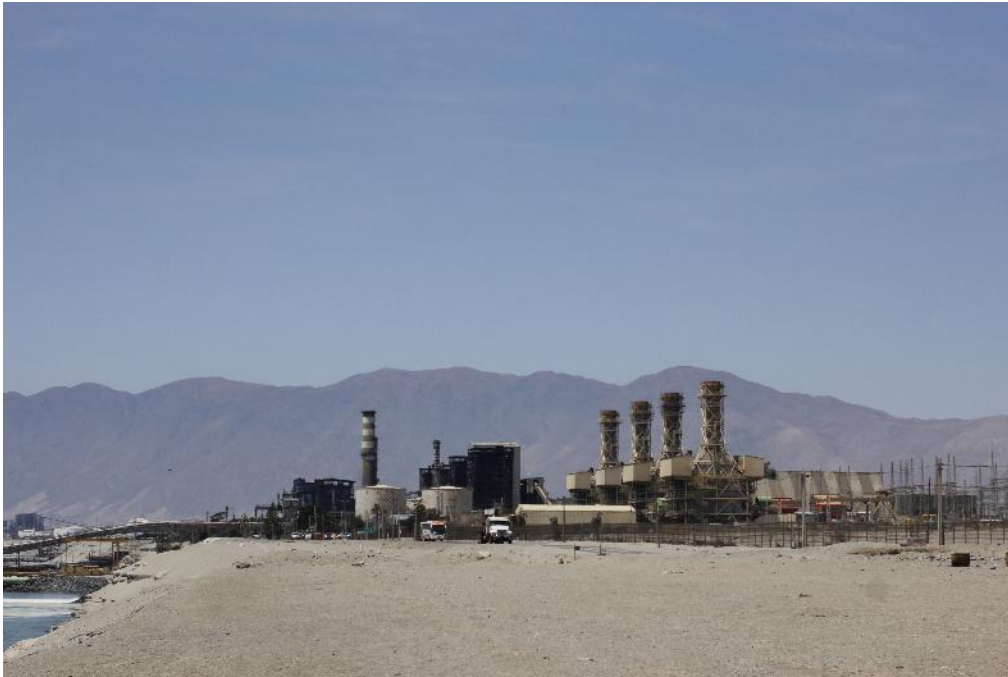
Figura 10. Infraestructura industrial y energética en el borde costero.
